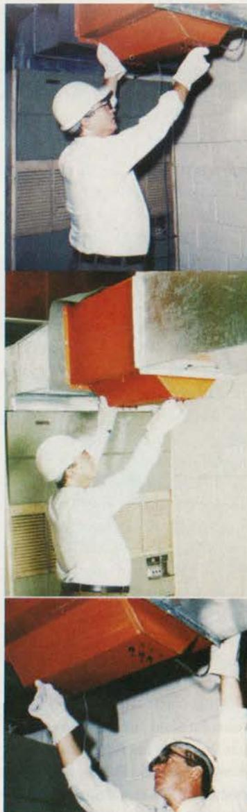
**Técnico instala sistema de ar-condicionado dotado de equipamento que combate microrganismos**
