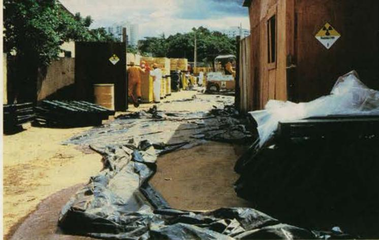
**Esta casa da rua 26 não foi demolida por apresentar baixa radioatividade. Portas e janelas, mais contaminadas pelo manuseio, foram arrancadas e as paredes raspadas. As plantas foram retiradas, a terra removida e todo o terreno concretado.**
