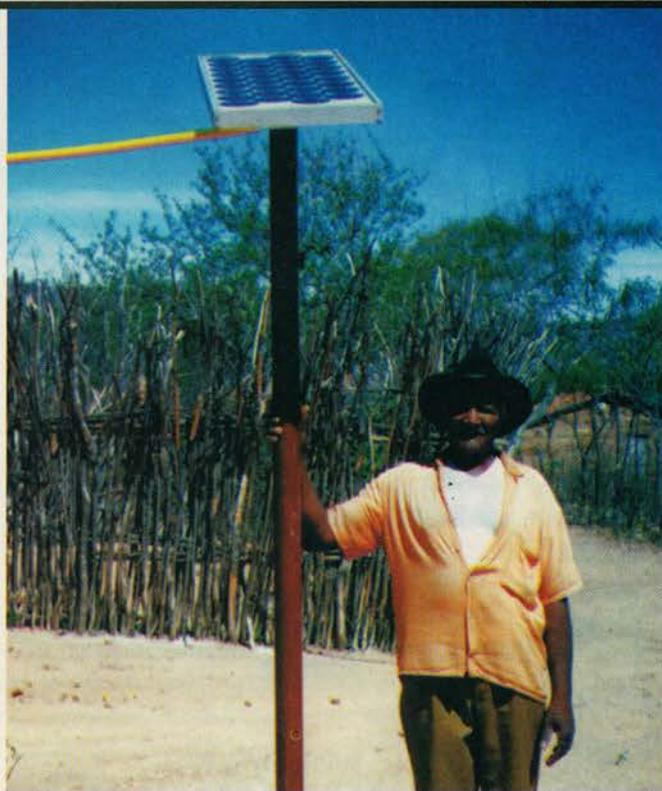
Sitante posa ao lado de um módulo fotovoltaico, onde se vêem as células solares. O sistema fornece eletricidade suficiente para iluminar quatro cômodos. A linha elétrica da Companhia de Eletricidade de Pernambuco passa a dois km do local.
