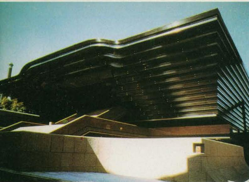
Fachadas do Reiuyukai Shakaden, construído em Tóquio, em 1975, utilizando 18,5 mil m<sup>2</sup> de painéis de aço preto para cobertura e revestimento. Esta é a maior aplicação de inox colorido já feita até hoje.
