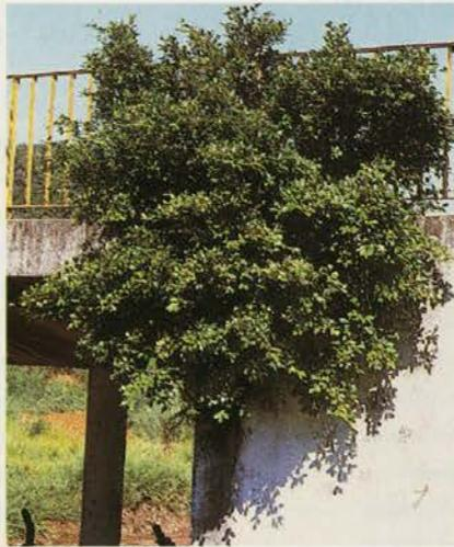
**Figura 5. Planta jovem de figueira-asiática crescendo em um viaduto, em São Carlos (SP). O detalhe mostra que o enraizamento da mesma planta está provocando rachadura na pilastra de sustentação do viaduto.**
