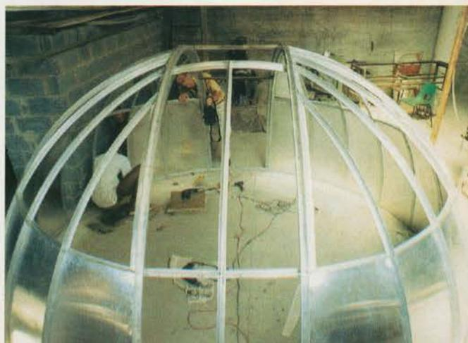
**Figura 2.** Montagem de uma cúpula de 4m de diâmetro, construída por Riedel para o Observatório Astronômico do Colégio Santo Agostinho, em Belo Horizonte, instalado no alto de um edifício de 13 andares.
