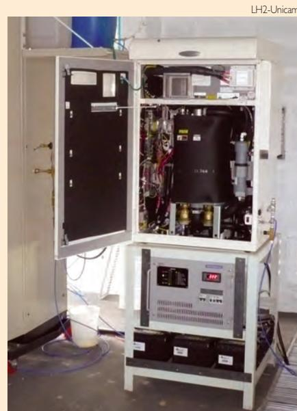
Reformador de etanol e da célula a combustível instalado na comunidade Pico do Amor, Cuiabá (MT)
