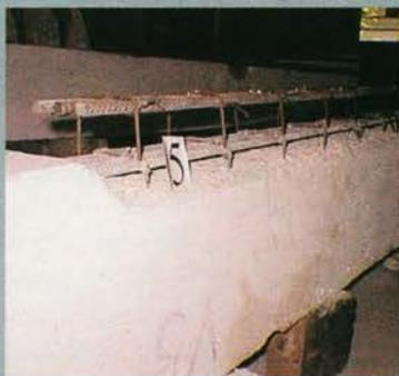
A parte inferior da viga recebe nova armadura (ferragem) de reforço, o que aumenta a altura em torno de 5 cm, dobrando a capacidade de carga
