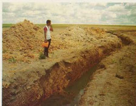
**Figura 1. Vala construída em área de brejo sobre chapadão do cerrado para drenagem de nascente.**
