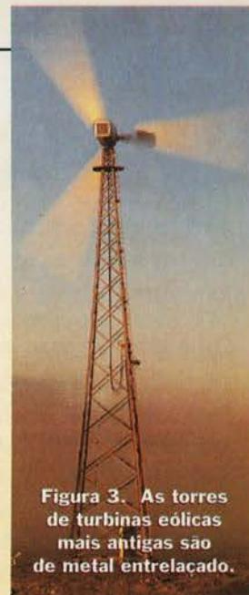
Figura 3. As torres de turbinas eólicas mais antigas são de metal entrelaçado.
